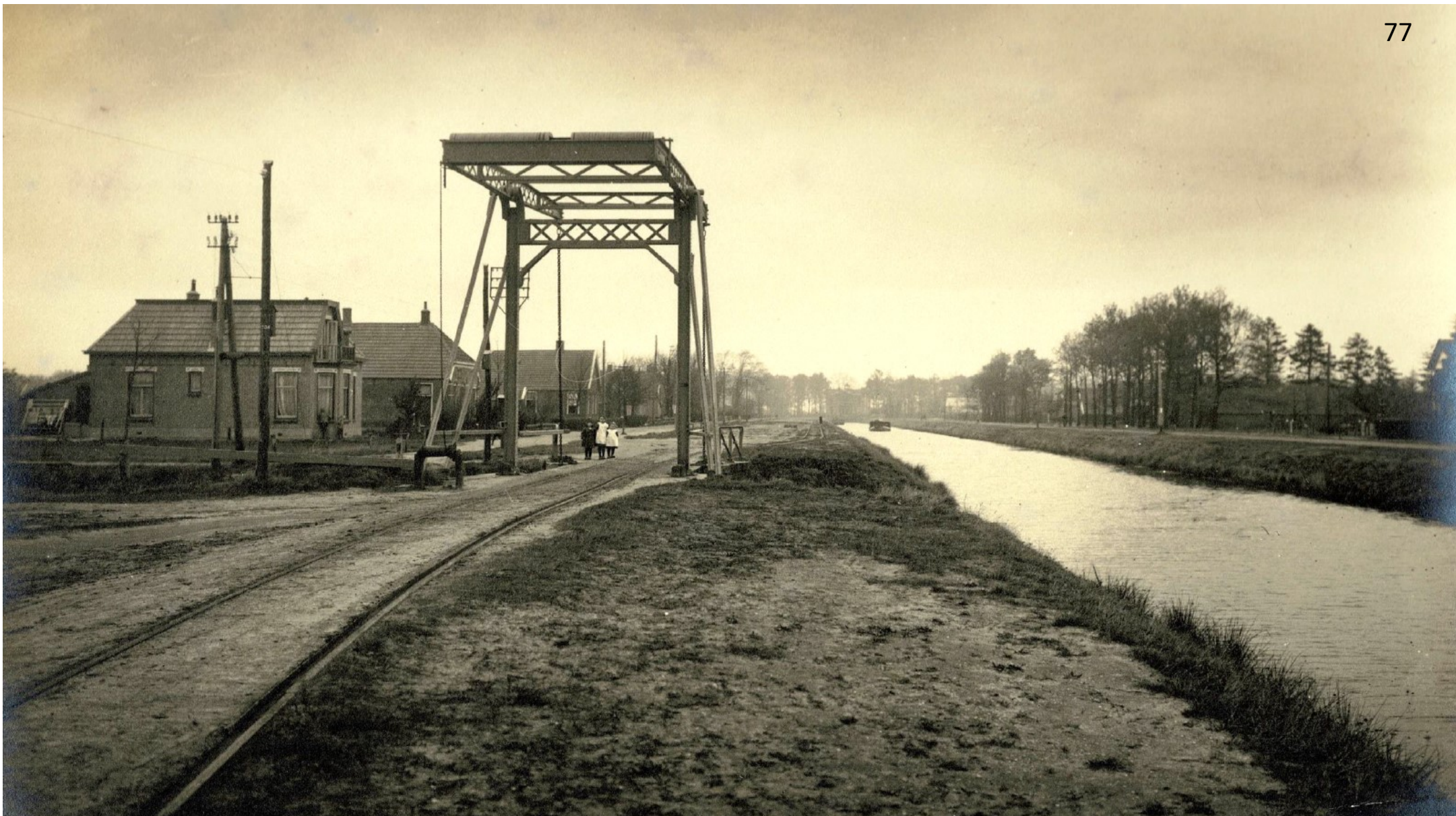
Nieuw Amsterdam 1923. De brug over de Kalkovenwijk, Zijtak WZ.
