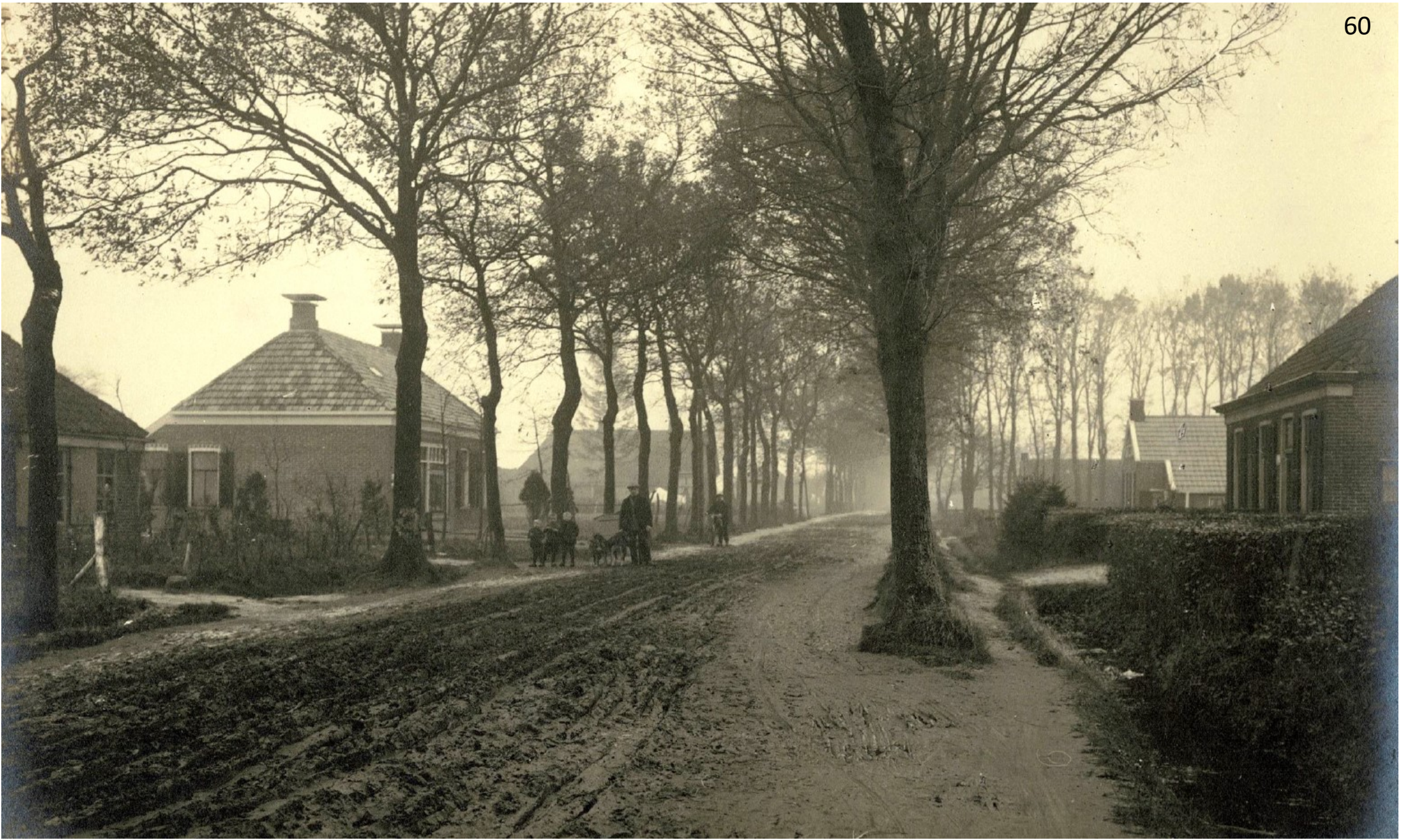
Veenoord— Nieuw Amsterdam 1923. De Schooldijk even ten noorden van de Eikenlaan. Het pand links is Schooldijk 20.
