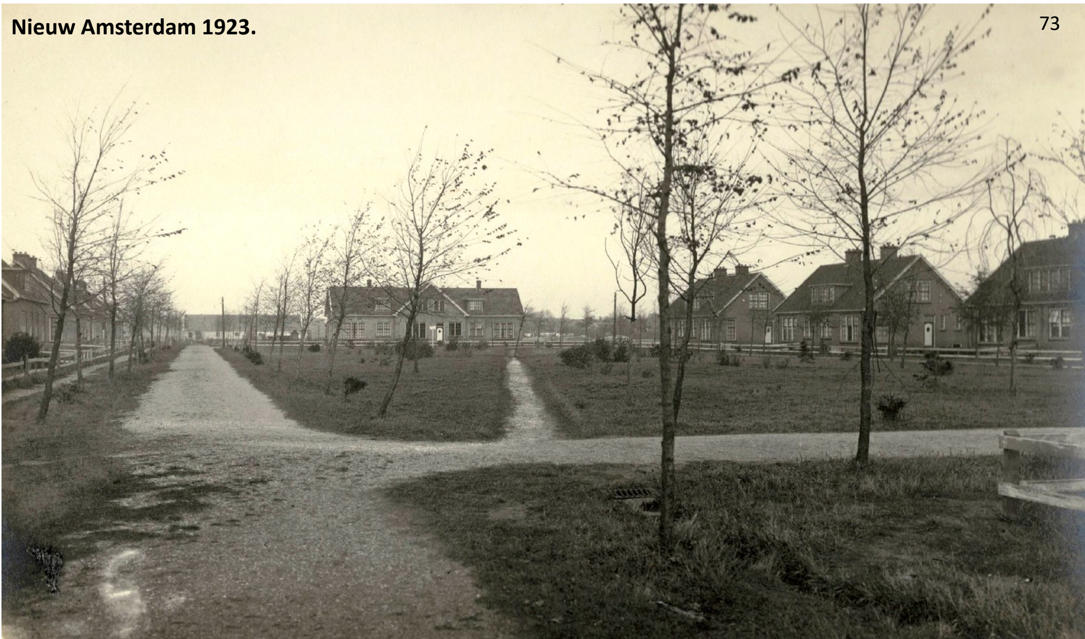
Woningbouwvereniging "Volksbelang" heeft in februari 1919 de bouw van deze woningen tussen de Leemweg (links) en de Zijtak aanbesteed, inclusief de aanleg van de wegen. Architect E H Bos Nieuw Amsterdam. Naar rechts loopt de Eggeweg. De bovenste woningen staan aan de Greind, de rechter woningen aan de Wisselweg.
