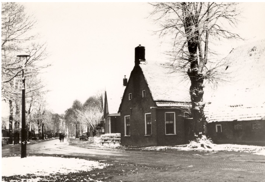
Op de foto links het pand op de hoek van de Eenerstraat en het Westeind, nr 16 op de kaart. Het pand is in de vorige eeuw al afgebroken. Alleen de boom staat er nog
